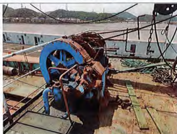
吊杆平台及设备
