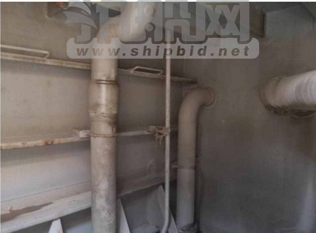
边压载舱结构、管路
