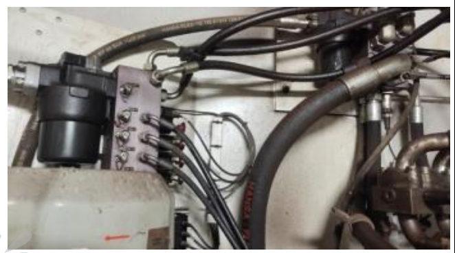
克令吊液压阀件及油管
