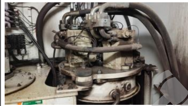
克令吊液压泵
