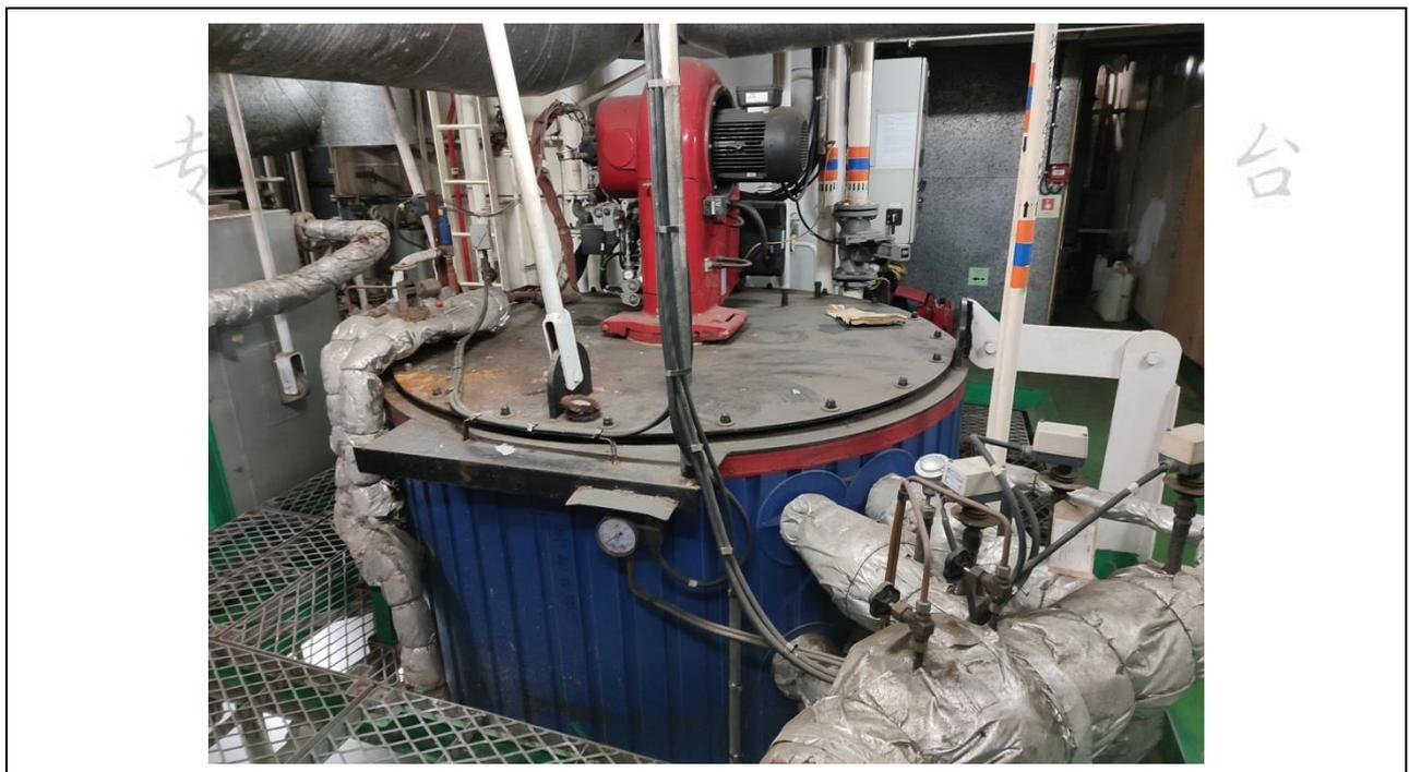
货油加热锅炉及点火装置
