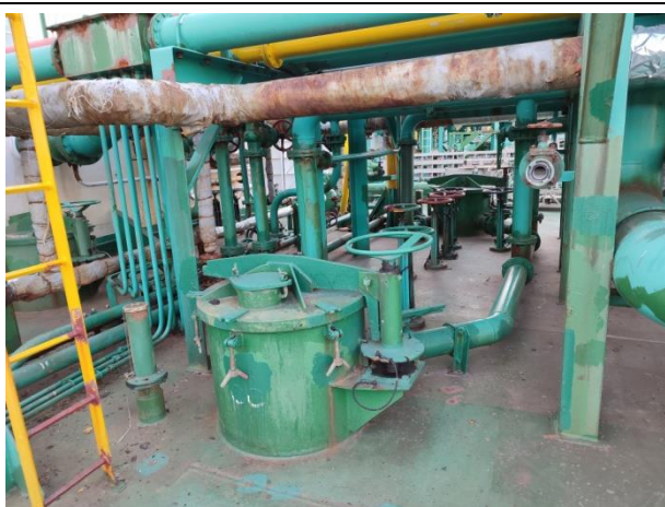
甲板电缆管路
